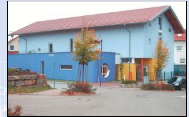
Nordansicht, fast fensterlos, gegen Energieverluste geschützt
