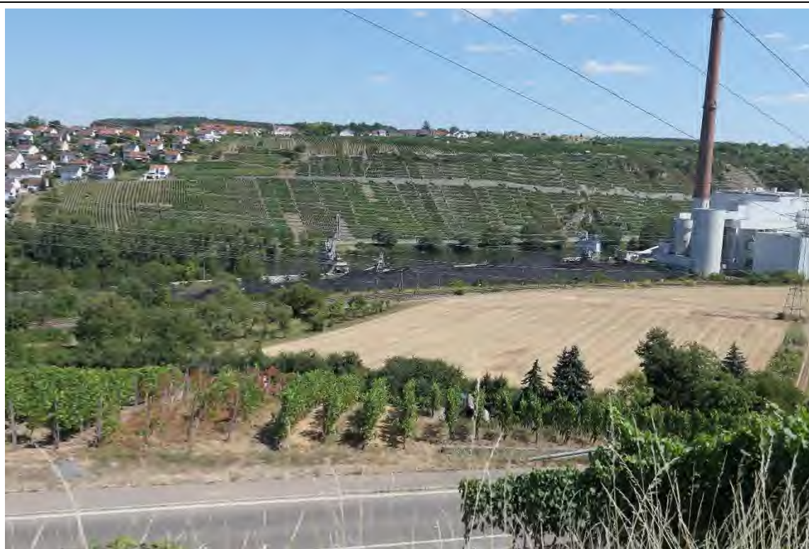
Blick von Walheim über den Neckar nach Osten auf die Weinbergsteilhänge südlich von Gemmrigheim. M. Koltzenburg, 08.08.2022
