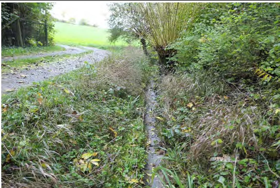
Sohlschalen im Talbach Flst. 4299. M. Koltzenburg, 26.10.2022
