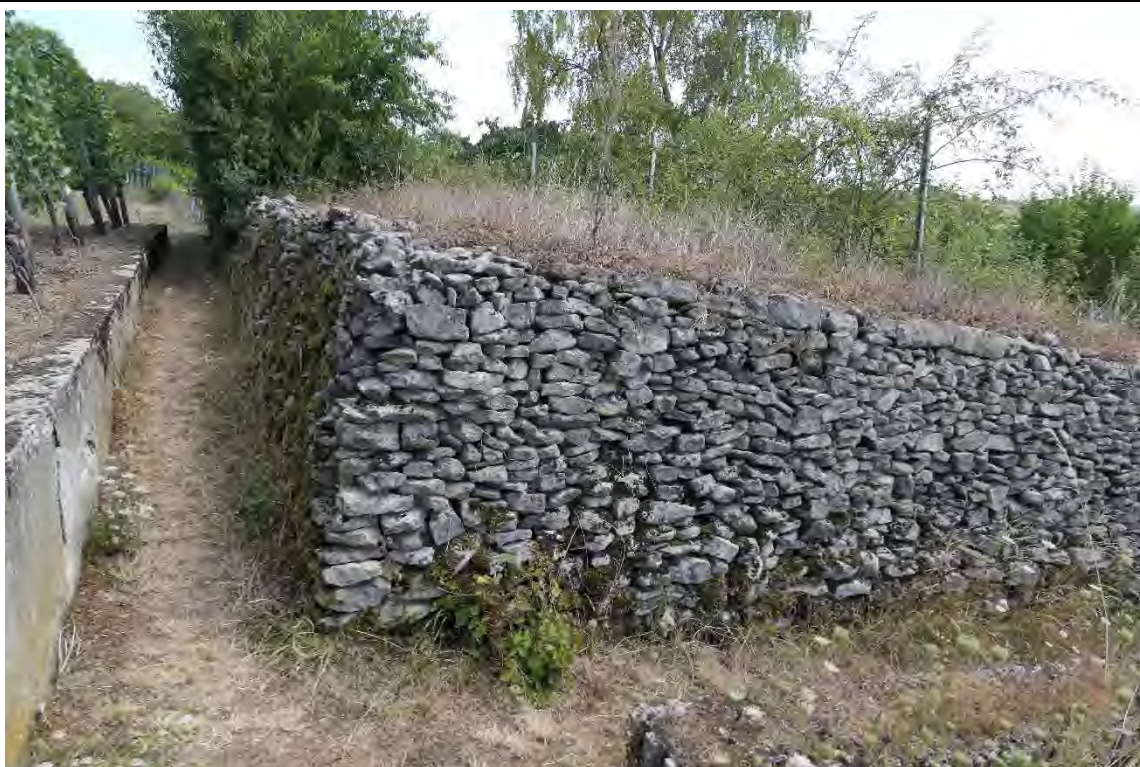
Mächtige Trockenmauer in der Buchhalde. M. Koltzenburg, 08.08.2022
