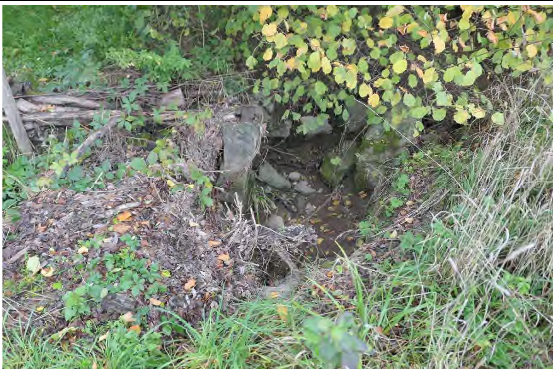
Verschütteter Talbach Flst. 4328/2. M. Koltzenburg, 26.10.2022
