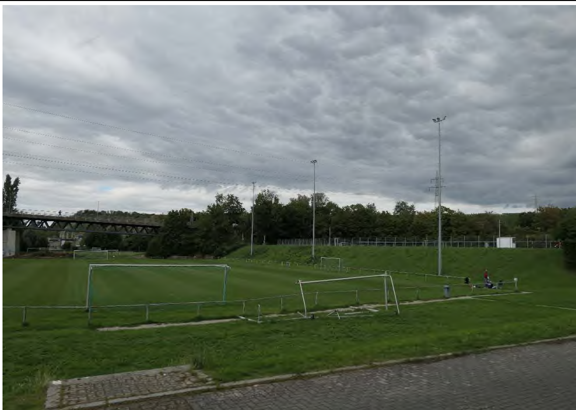
Flutlichtanlage auf dem Sportplatz an der Wasenhalle- M. Koltzenburg, 07.08.2023
